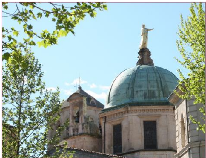
Figure 27 : La Cathédrale depuis la place Carnot : vue sur le dôme couronnant la chapelle royale, construit au XVII e siècle et sur le clocher roman quadrangulaire, érigé sur la croisée du transept.
