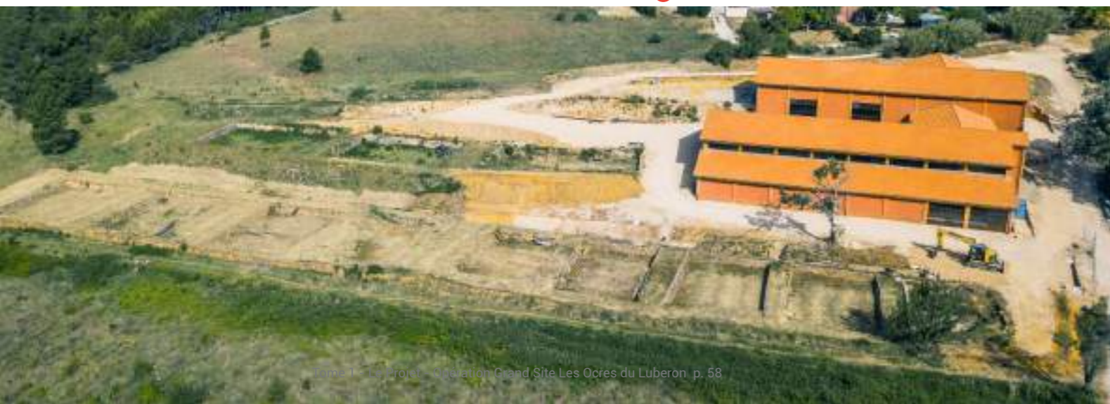
1 Anciens bassins de lavage et séchage de la Choque - Gargas
