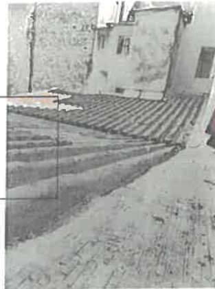
Toiture cours parcelle 307
