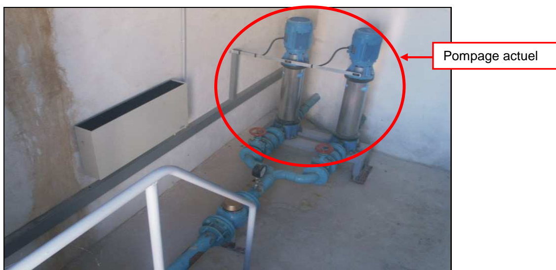
Figure 6-22 : Emplacement actuel des pompes au réservoir de Saint Martin Haut Service
