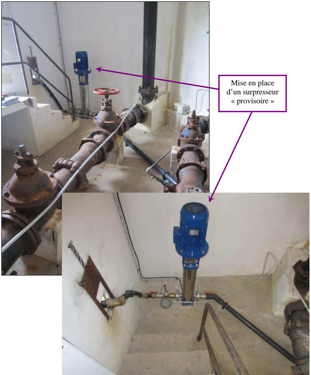
Figure 4-3 : Surpresseur de Saint-Michel mis en place provisoirement – été 2012
