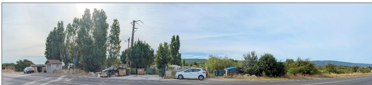
Photo 1 : Vue globale du site depuis la RD 70
